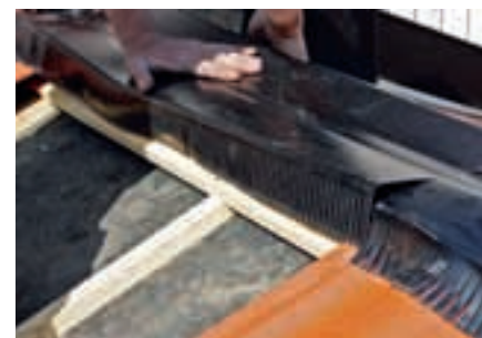
Kent Brands takfot hindrar bland annat yttersta pannan från att hänga ner mot rännan. Tacknocken (t h) i två delar ger en tät och raknock.
