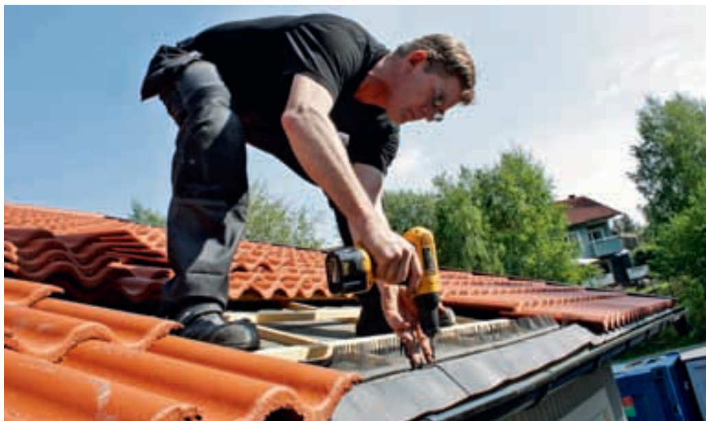
Kent Brands takfot hindrar bland annat yttersta pannan från att hänga ner mot rännan. Tacknocken (t h) i två delar ger en tät och raknock.
