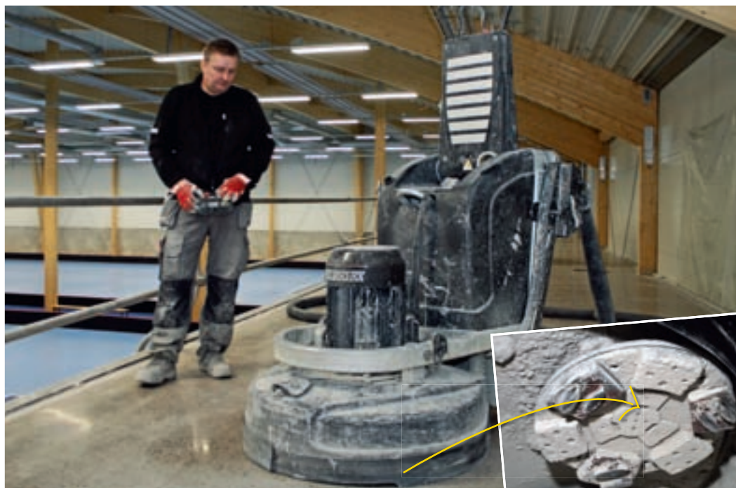
På den stora roterande slipskivan sitter det fyra mindre slipskivor. På var och en finns konstgjorda diamanter.
