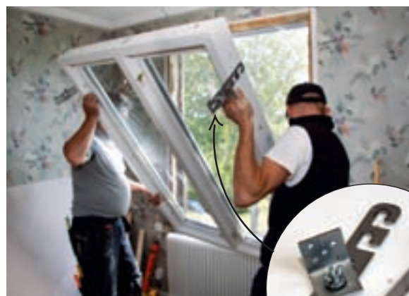
Fixturen består av tre delar: en längre bygel, ett vinkelbeslag och ett skruvförband som håller ihop bygeln och vinkeln.
