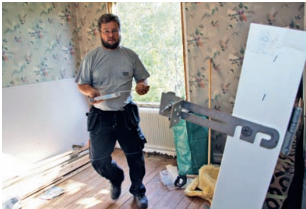
Clas Anderssons nya hjälpmedel för fönstermontering sätter både kilar och mothåll.
