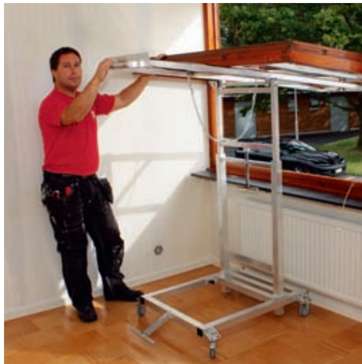
Kent Thuresson låter fönsterlyften göra grovjobbet. Tidigare behövdes två personer för att lyfta av pivåhängda svängfönster.
