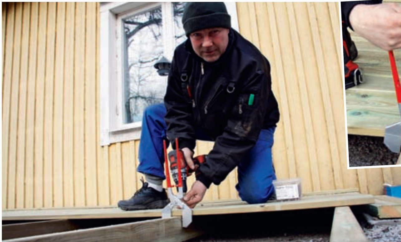
Dag Melanders tång kläms fast genom att de övre stiften pressas in i virket. Sedan pressar man trallbrädan lätt inåt och fixerar brädan med de kortare stiften.
