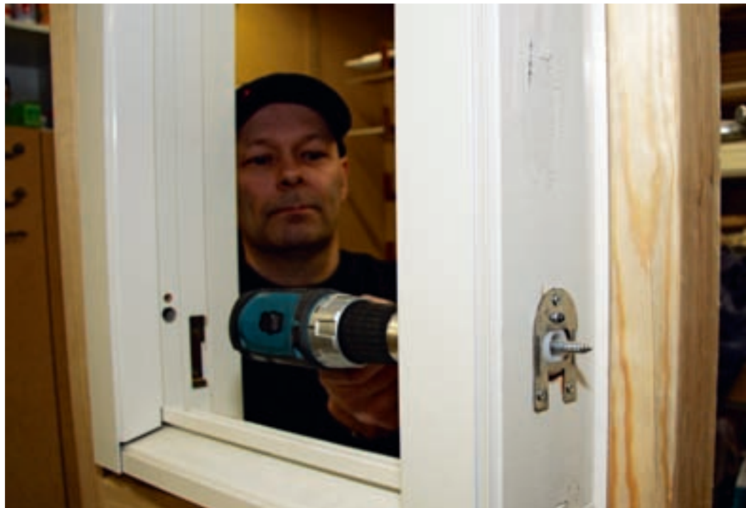
Peter Cernolds justerbara fäste fälls in i karmens utsida. Karmskruvor monteras på vanligt sätt med skruvdragare och sexkantshylsa.
