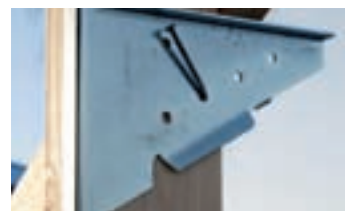
För bredare regler används ett beslag som fixeras med en spik.
