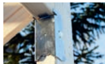
Beslaget har u-form och passar de vanligaste standardreglarna.
