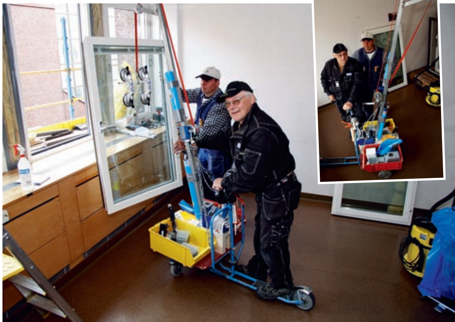
Hans Hoof (vänster) och Sven-Egon Lundström slipper ryggont. Med den ombyggda sparkcykeln lyfter de lätt tunga fönster.
