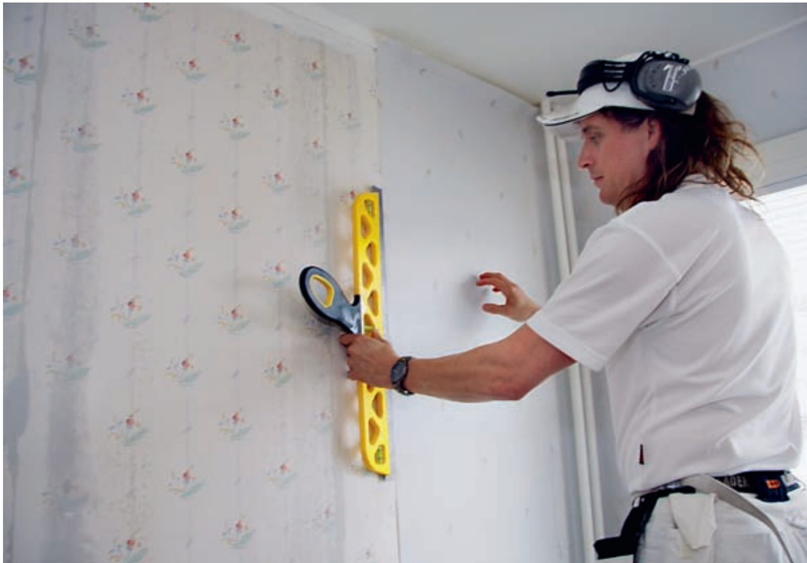
Niclas Rydéns kombiverktyg för målare ersätter vattenpasset, tapetrivaren, linjalen, skärklossen, lodet, måttstocken och bredspackeln.
