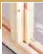
Tore Karlströms nya väggregel har ett nyckelhålsformat spår i mitten. Stående och liggande regler hålls ihop av en träkil som slås ner i spåret.
