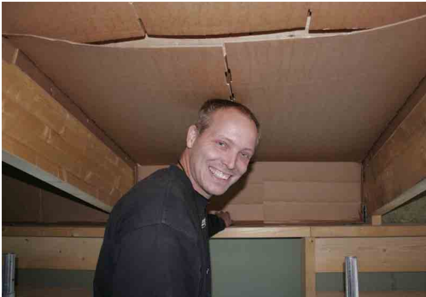
Johan Bergdahl isolerar taket med wellpappskivor i stället för masonitskivor. Wellpappen viks så att en luftspalt bildas mot taket.
