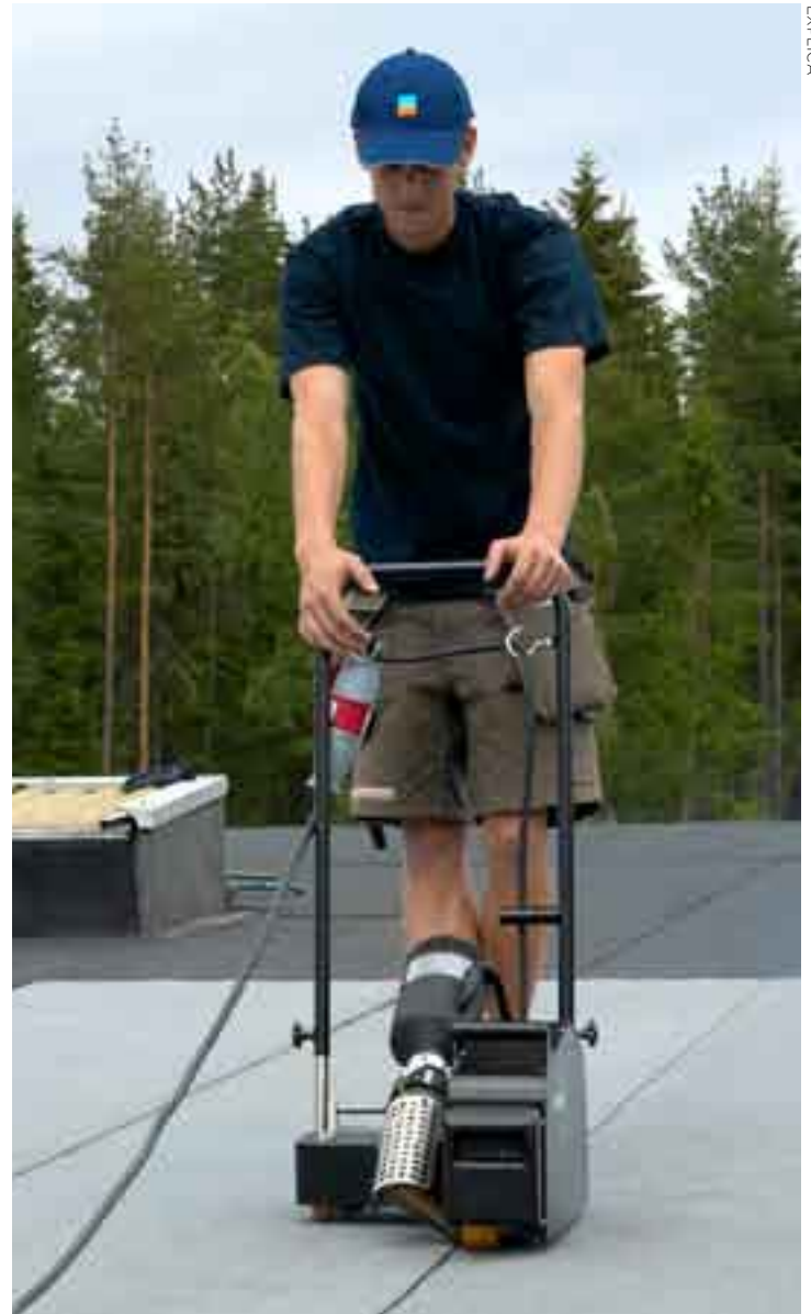
Den eldrivna varmluftsmaskinen smälter och pressar samman fogarna i samma moment. Fem centimeter breda skarvar räcker.
