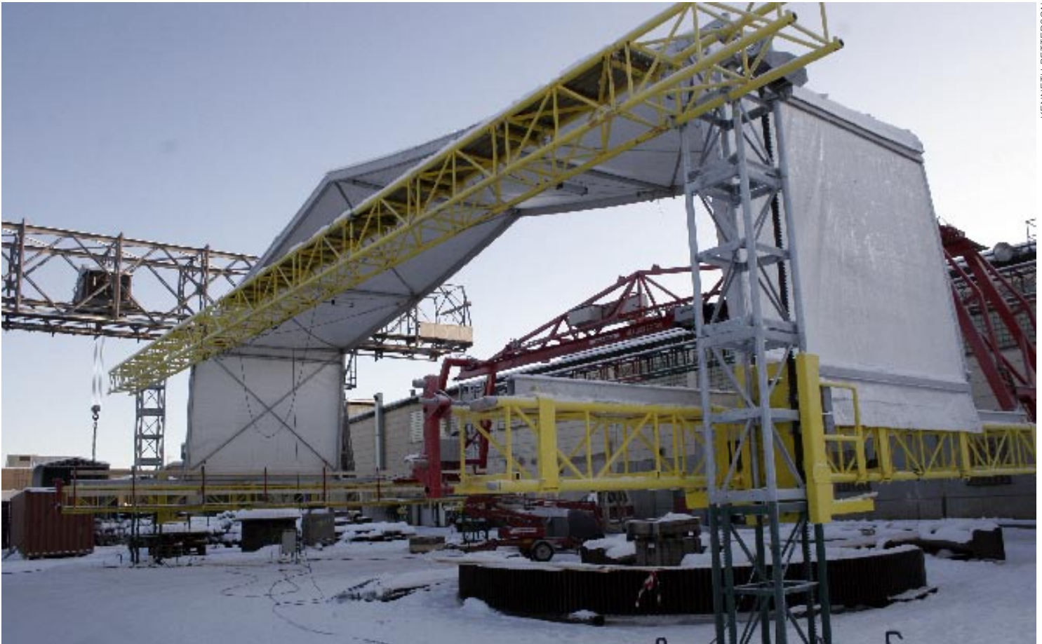
Det klättrande väderskyddet med bockkran, här i prototyp med endast en tältsektion, premiärvisades i januari hos företaget Industriteknik Nord AB i Boliden. Bockkranen i bakgrunden rullas in under tältet så att all hantering av last sker skyddat från väder och vind.
